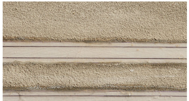
Detailansicht der Folien-Grundlage: Kiesfläche mit Streusand.
